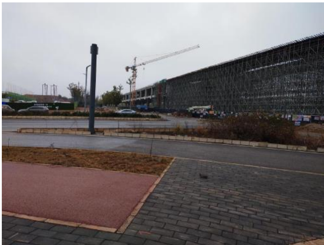
图 4-5 调查地块东南面现场踏勘图
