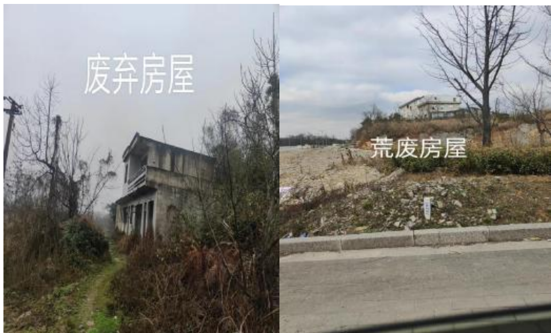
图 4-8 调查地块 ZG-08-01 内废弃居民用房现场踏勘图
