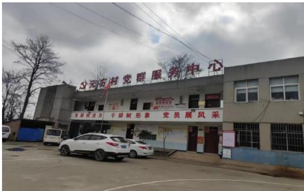
图 4-12 地块西面元方村党群服务中心现场踏勘图
