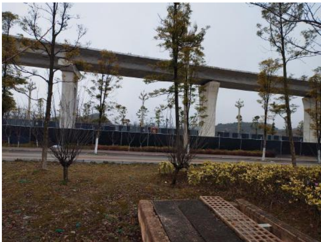
图 4-2 调查地块南面现场踏勘图
