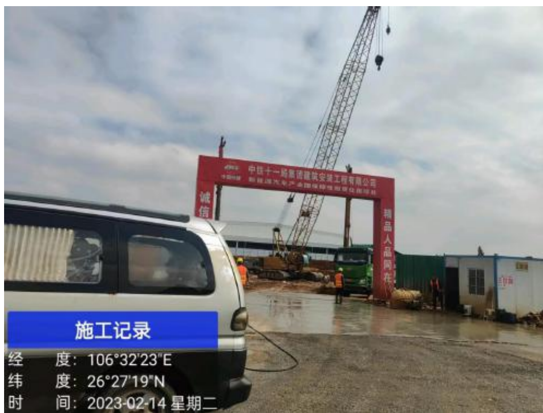
图 4-13 地块东南面中国铁建新能源汽车产业园保障性租赁住房项目现场踏勘图
